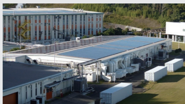
和歌山工場 2022年11月増設
