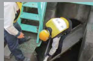
農業用水取水口への蓋の取り付け
