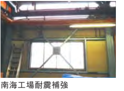
南海工場耐震補強
