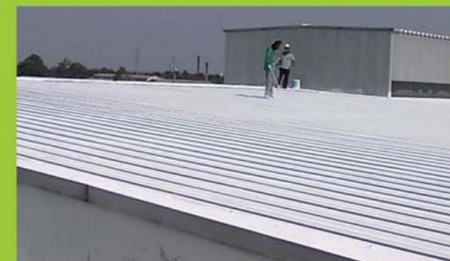
工場屋根セラミックコーティングの様子
