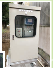
足利工場に設置した水質監視装置
